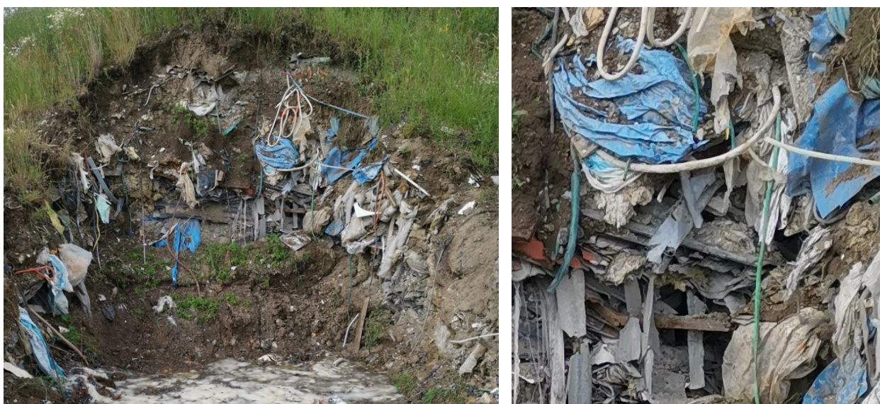
Figur 2.3 Afgravning i siden på en ellers færdigetablet celler for blandet affald med asbest- og eternitaffald. Til højre er den midterste del af fotoet forstørret, så man bl.a. kan se hulrummene mellem forskellige affaldstyper.
