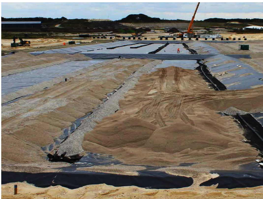
Foto: Etablering af nye celler på Glatved Deponi
