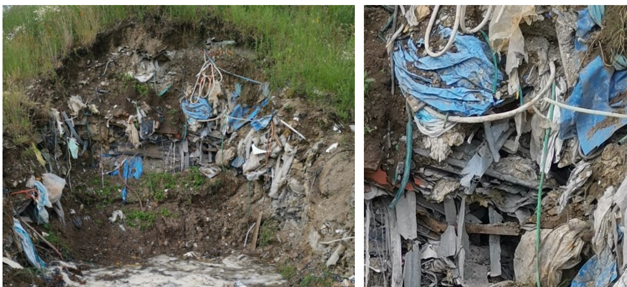
Figur 2.3 Afgravning i siden på en ellers færdigetableret celle for blandet affald med asbest- og eternitaffald. Til højre er den midterste del af fotoet forstørret, så man bl.a. kan se hulrummene mellem forskellige affaldstyper.
