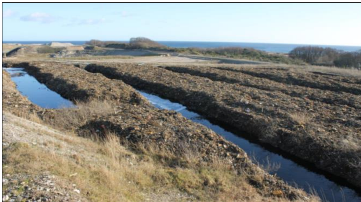
Figur A6.3: Grøfter til recirkulering af perkolat på toppen af en enhed med shredderaffald på Etape II på Reno Djurs (fra Rolsted and Rosendal (2016)).
