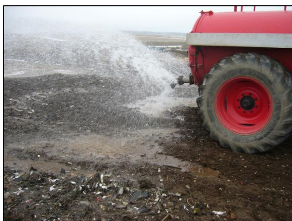
Figur 2: Udspredding af rent vand over nyligt deponeret shredderaffald på Reno Djurs ved hjælp af en tankvogn i 2010.
