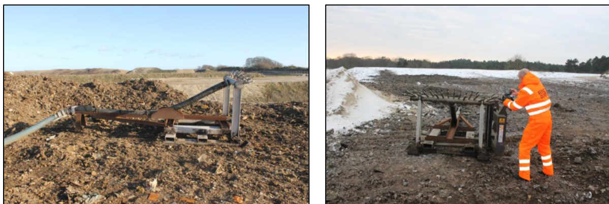
Figur 4: Perkolatspredningsanordningerne ved Reno Djurs (fra Rolsted and Rosendal, 2016).
