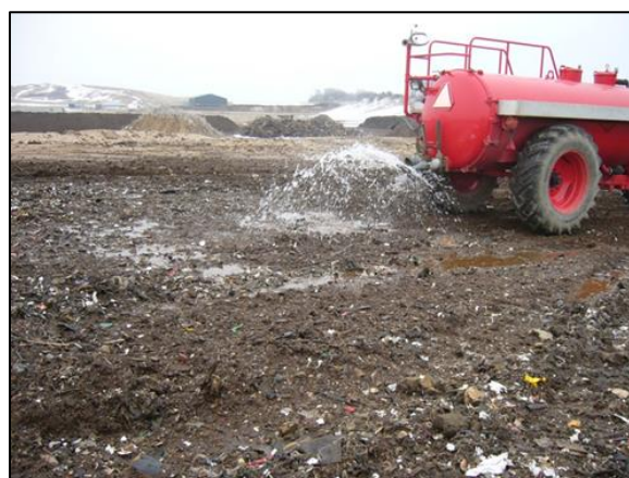
Figur 2: Udspredding af rent vand over nyligt deponeret shredderaffald på Reno Djurs ved hjælp af en tankvogn i 2010.
