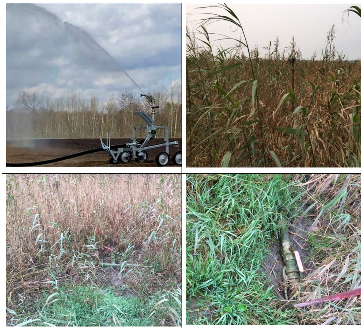
Figur 4: Elementer af recirkuleringssystemet ved Miljøcenter Gerringe. Øverst tv.: En sprinklerenhed (ikke same type som anvendt ved Gerringe). Øverst th.: Et sprinklerhoved på Gerringe deponeringsanlæg. Nederst: Forbindelsesrørene til hver af de parallelle fordelingsrør. Fotos: Andersen (2017).
