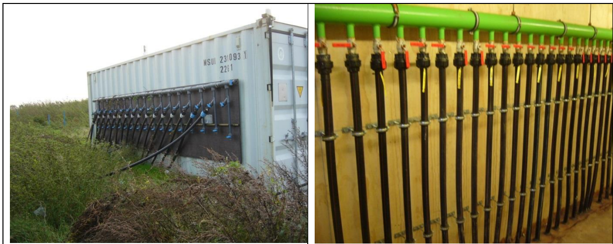
Figur 4: Fordelingscontaineren på toppen af etape A. Til venstre ses ledninger til gasopsamling uden på containeren, og i baggrunden ses plastrør til markering af endepunkterne for nogle af U-drænrørsledningerne. Til højre ses fordelingsmanifolden til de nedgravede drænrør inde i containeren.
