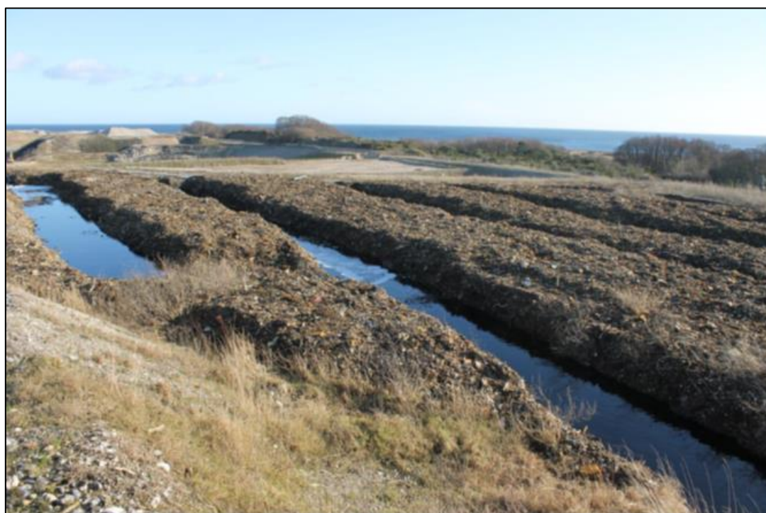
Figur 5: Grøfter til recirkulering af perkolat på overfladen af deponeringsenhed A med shredderaffald ved Reno Djurs (fra Rolsted and Rosendal, 2016).
